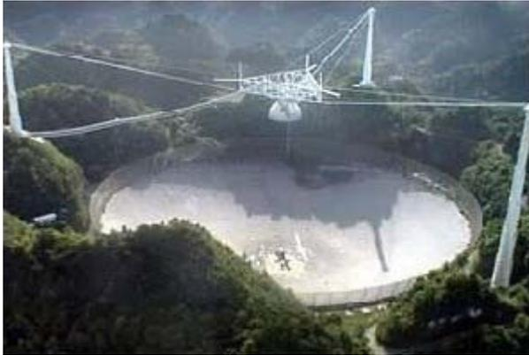
**Figure 42** : antenne fixe de 300 m de diamètre de l'observatoire radioastronomique d'Arecibo installée à Puerto Rico
